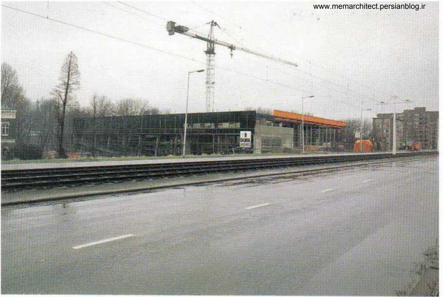
Foto: Sul sito edificio in costruzione. Dicembre 1991 / South view of the building under construction. December'91.
